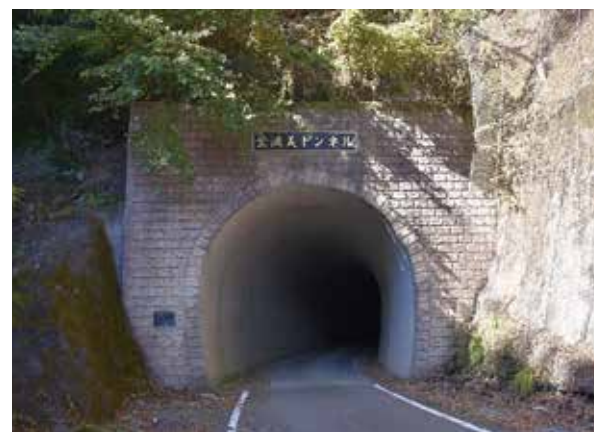
林道 金波美線(上野原市)「金波美トンネル」L=174m
