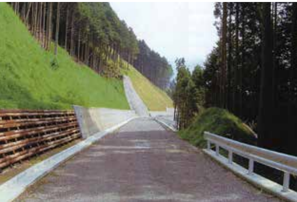
広域基幹林道三石山線(南部町)
