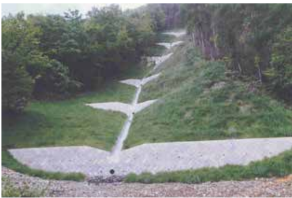
山腹工(御坂町)
