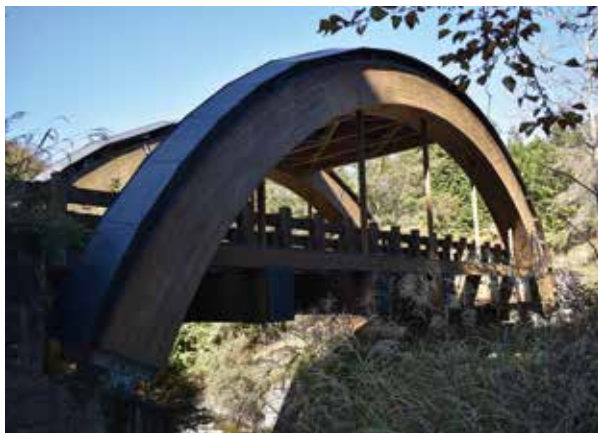
林道 鹿留線(都留市)「虹の木橋(木橋)」L=23m
