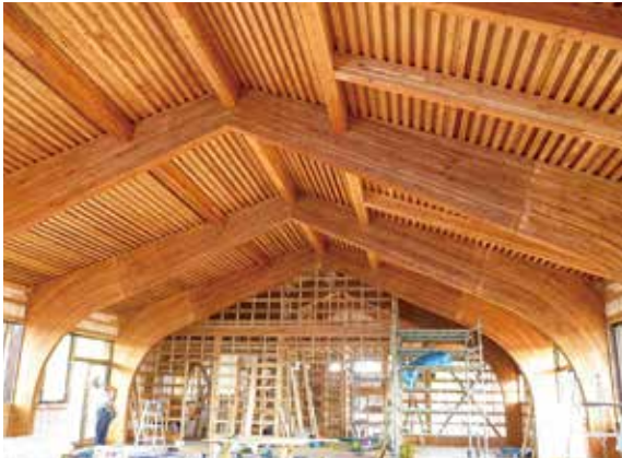
建て込み完成
