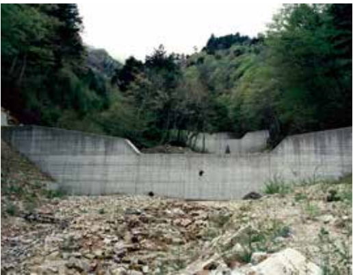
治山ダム (下部町)
