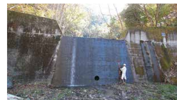
治山施設の点検
