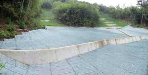
山腹工による災害復旧後（令和3年）
