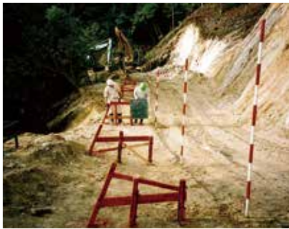
現場監督業務(擁壁工丁張り確認)
