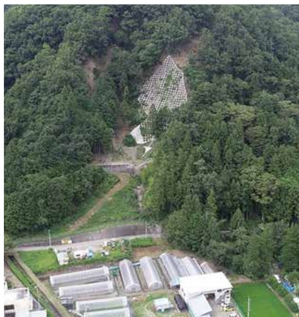
山地災害リスクを低減する治山施設 (山梨県南巨摩郡富士川町地内)
