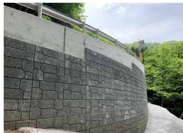
高排水性垂直擁壁工
