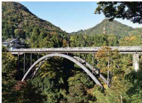
林道 富士東部線(大月市)「梁川大橋」L=120.8m
