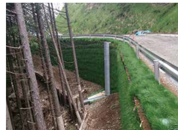
補強土壁工
