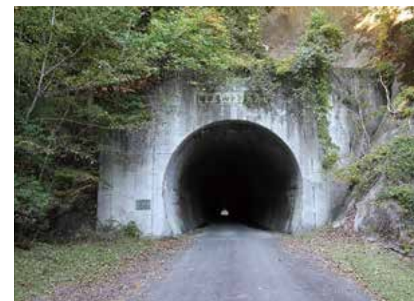
林道 富士見山線(身延町)「富士見山トンネル」L=293m
