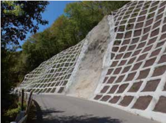
復旧した法面
