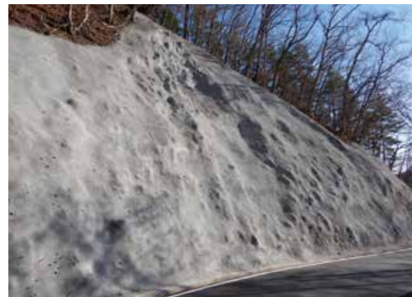
モルタル吹付工
