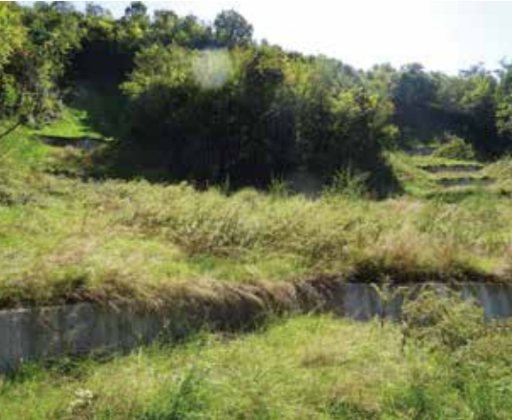
復旧が進む山腹工（令和4年）
