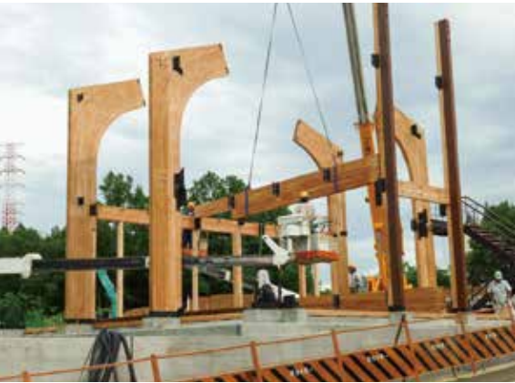
移築先での構造材建て込み
